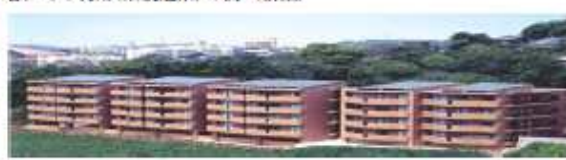
名 称：「アドハンス21 貴船」（山口県下関市） 設 置：容量 51kW 専有部 3kW × 16戸 = 48kW 共用部 3kW
