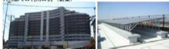
名 称：「シーズガーデングリーンパティオ」（埼玉県鳩ヶ谷市） 設 置：容量 10kW
