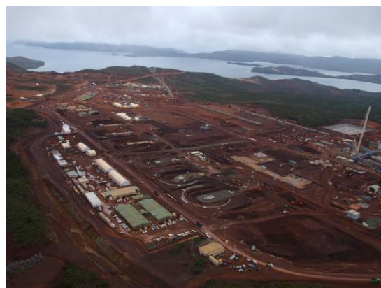
写真 3 ゴロー鉱山に建設中の工場
