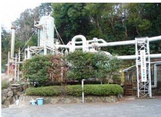
蒸気井から蒸気と熱水が気水分離器へ
